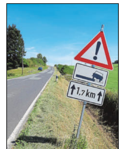
Die Straßendecke der K 62 wird erneuert. Foto: J. Vahle
